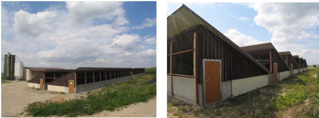
Abb. 2: Ansicht des Außenklimastalles am Betrieb 1 (links zwei Abteile westlich des Zentralgangs, rechts sechs Abteile östlich des Zentralgangs)
